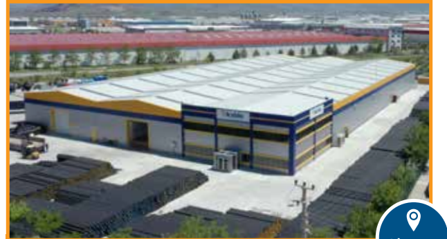
Koroze Sistemleri Üretim Tesisi
