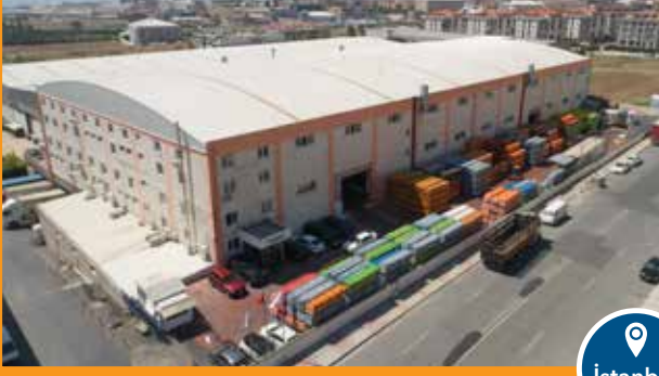
Vana ve PP-R Sistem Üretim Tesisi
