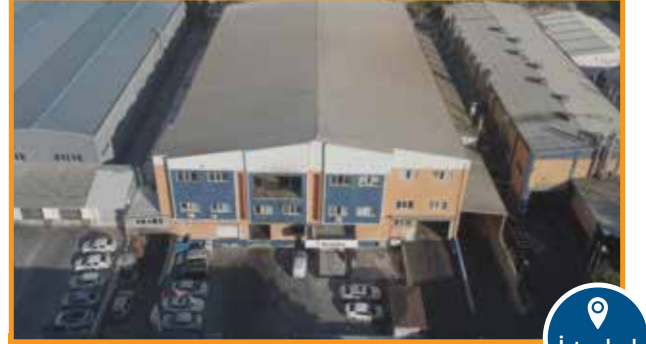
Metal Üretim Tesisi
